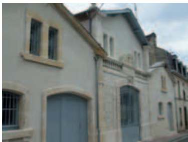
Chais réhabilités en logement individuel © Ville de Cognac
